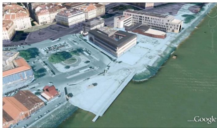
Subida do nível médio da água do mar no Cais do Sodré.
