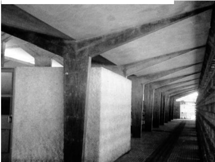
Fig. 60 Vista interior do Mercado do Caputo Fonte: http://cargocollective.com/arquiteturamodernaluanda/Mercado-de-CaputoFernaosimoes-de-Carvalho-1962En-uso
