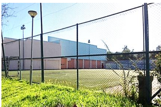
Figura 19 – Pavilhão Gimnodesportivo e campo exterior.
