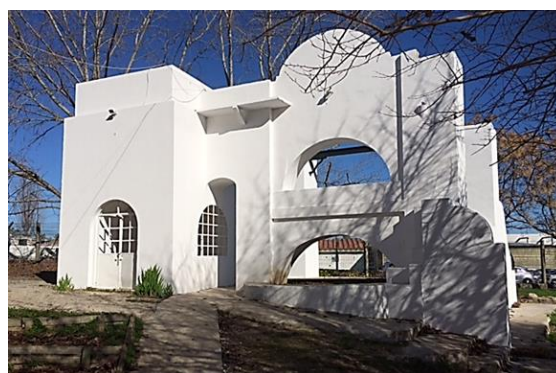
Figura 20 – Antigo Poço (recuperado).
