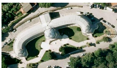
Fig.59 – Fotografia aérea do Pavilhão de Exposições (Fonte: http://maps.google.pt ).
