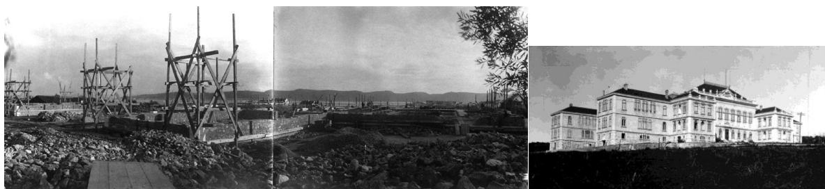
Figs.62 e 63 – Fotografias da construção e do Edifício Principal do I.S.A., há mais de 100 anos atrás (Fonte: https://www.isa.utl.pt/files/priv/fotos/Construcao_Edificio_Principal/fotos ).
