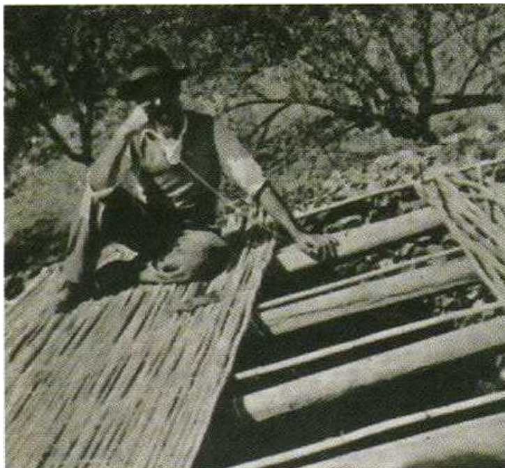
Figura 18: Execução de um telhado constituído por telha argamassa e assente num "encaniçado"
