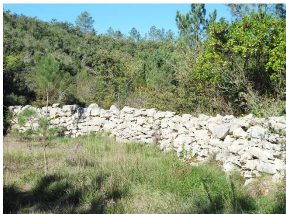
Figura 40 – Muro de pedra seca
