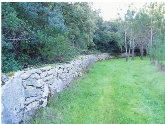
Figura 39 – Muro de sustentação de terras
