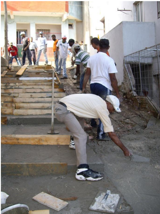
FIGURA 26 | CONSTRUÇÃO DE ESCADAS PELA COMUNIDADE, COVA DA MOURA, LISBOA
