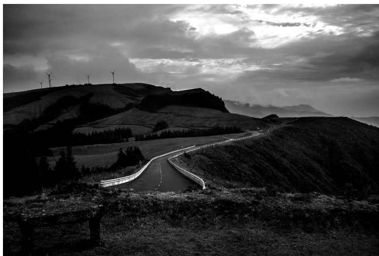
57 Estrada em São Miguel
