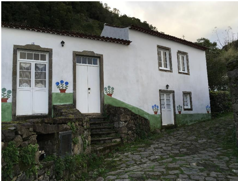
187 Exterior da casa José Branco (8)
