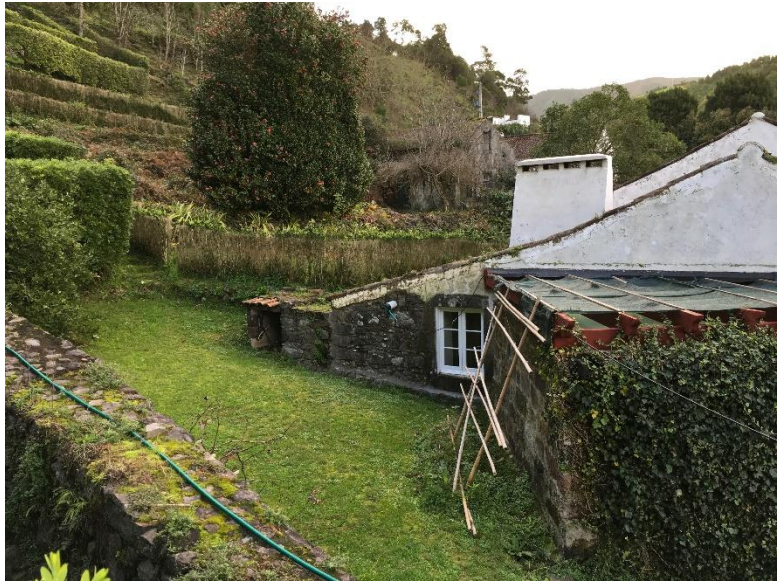
188 Exterior da casa José Branco (8)
