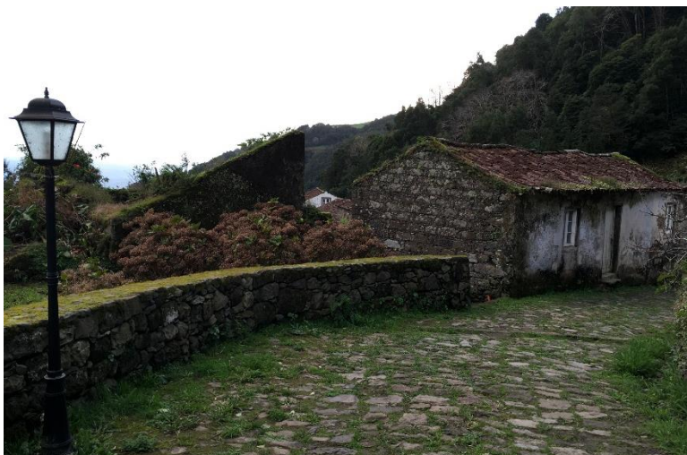
212 Exterior das ruínas (10)
