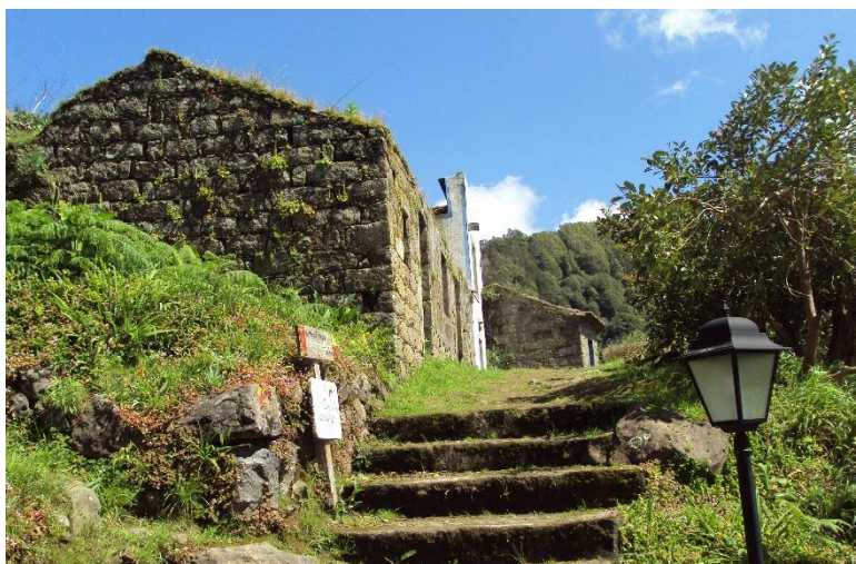
119 Fotografia da casa Natália, Torreão e Ruína (3)
