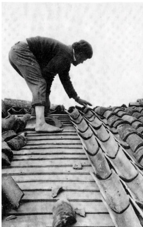
6 Calhetas, São Miguel, reconstrução de cobertura com telha de meia-cana
