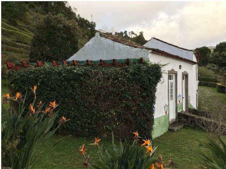
189 Exterior da casa José Branco (8)
