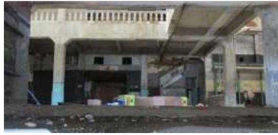
Zona Escritórios, 2017 Fonte: do próprio
