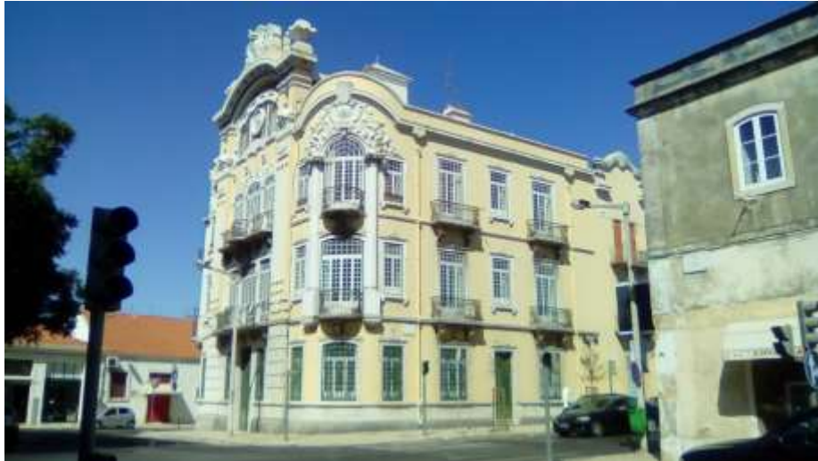
Fig. 5. Vista atual do Edifício José Domingos Barreiros, 2017
