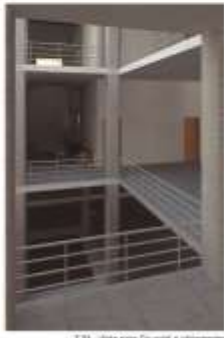
7.04 - Vista com Corrimão e vidrarias
