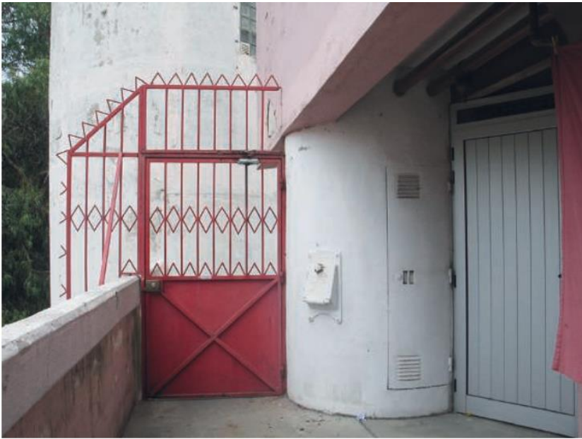
Fig. 20 | Intervenção na galeria do edifício Pantera cor-de-rosa
