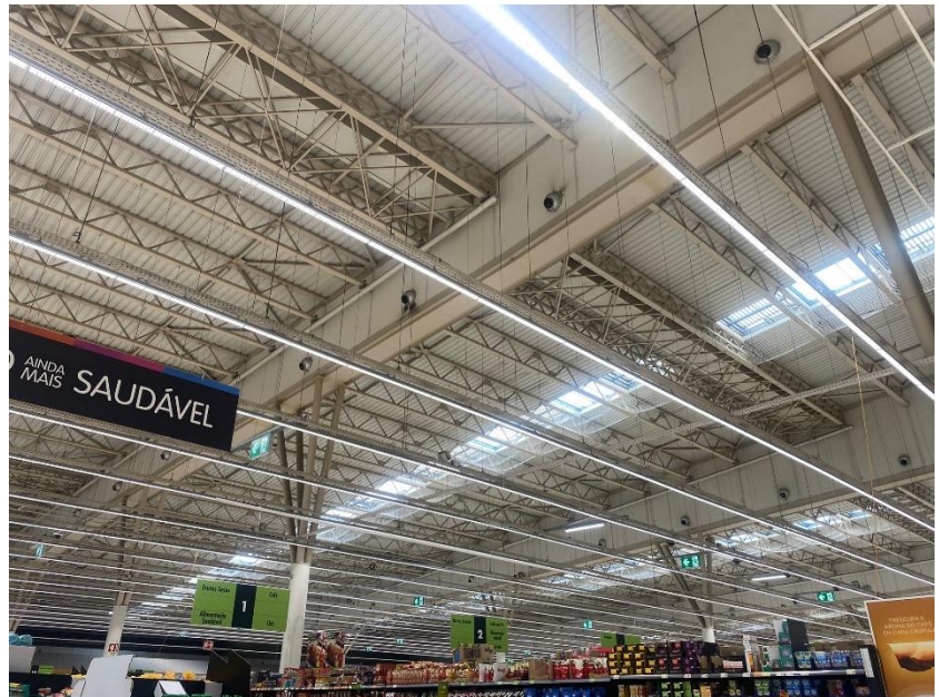
Fig. 71 | Estrutura metálica Pingo Doce centro comercial de Bela Vista
