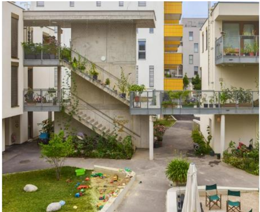
Fig. 28 | Vista de acessos verticais e horizontais do complexo habitacional Sonnenblumenhäuser
