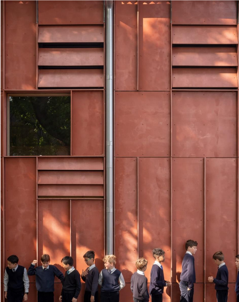
Fig. 73 | Revestimento em viroc, David Brownlow Theatre,
