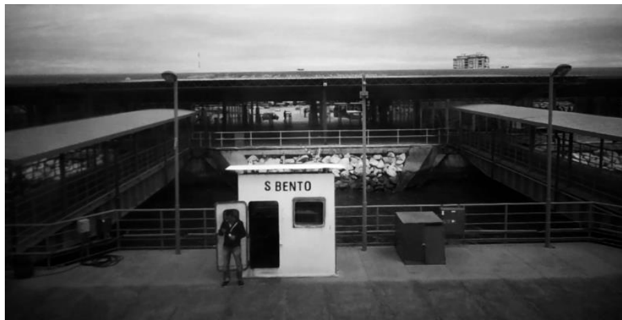
Figura 110 Fotografia, Chegada ao Cais Fluvial do Barreiro , Barreiro, da autora, 2016
