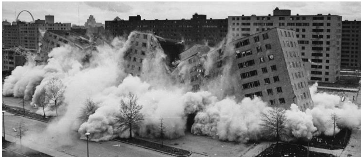
Figura 12 Fotografia, Demolição do Complexo Pruitt Igoe , St. Louis, Missouri, 1973
