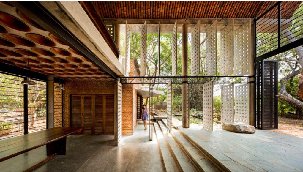
Fig. 15 - Exterior da Casa da Parede, com os blocos de terra produzidos em Auroville, projetada pela Arquiteta Anupama Kundoo . Javier Callejas e Alka Hingorani . 2014
