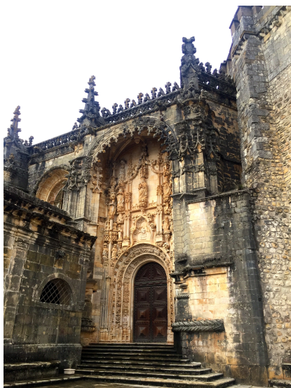
Figura 18. O portal sul. Fonte própria.
