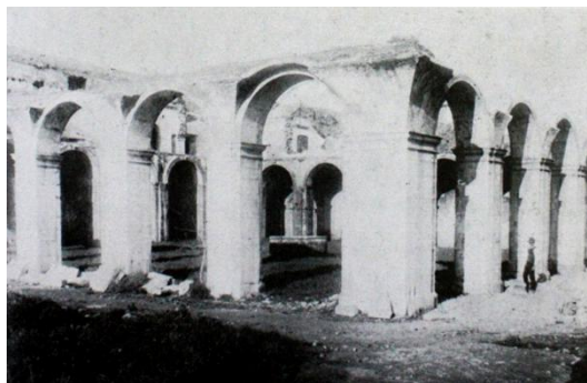
Figura 22 - Fotografia do claustro na altura da sua demolição
