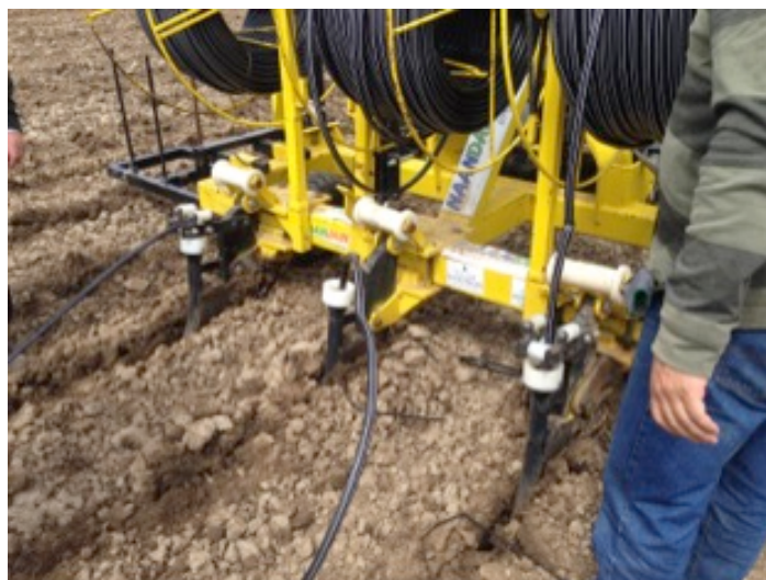
Figura 5. Instalação das rampas a 35 cm de profundidade e separados a 75 cm, E.E.A.T. Fonte: Autor.
