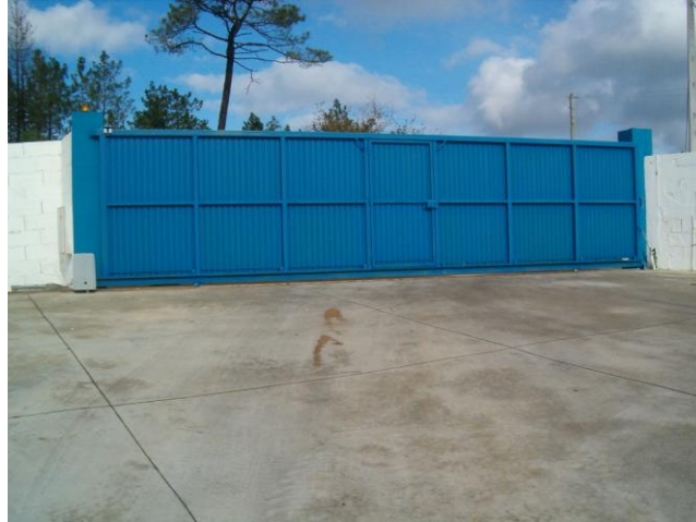
Figura 5- Portão eléctrico à entrada da unidade de produção.
