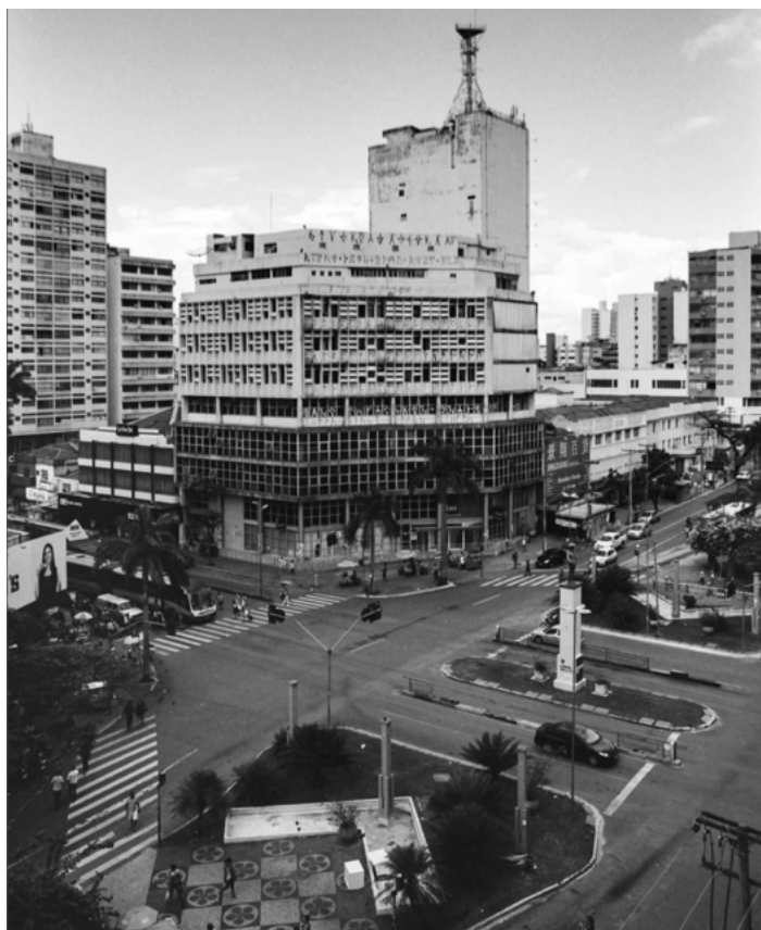
Figura 13 - reduzido espaço remanescente da praça original que abriga o monumento 22
