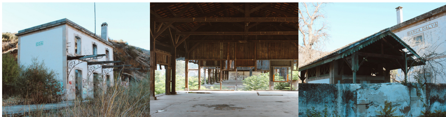
Figura 7 Estação ferroviária abandonada do Côa Fotografia da Autora
