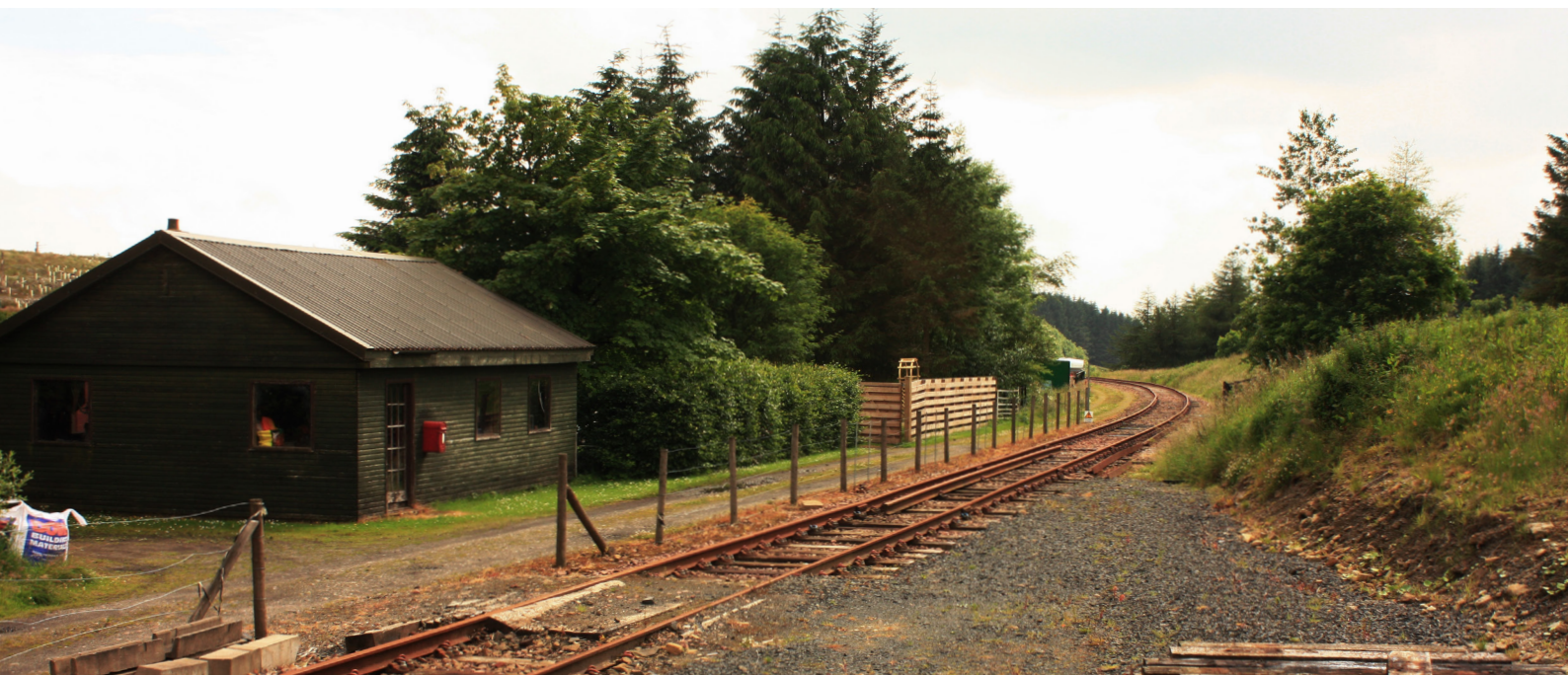
Figura 51 Linha férrea de Waverley Fotografia de Nerea Oroquieta
