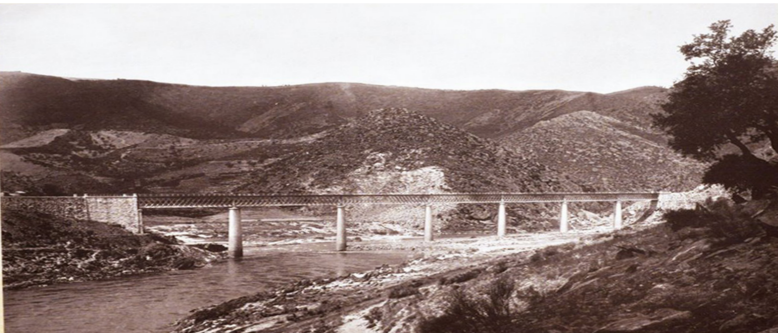
Figura 12 Ponte do Douro, vista da margem direita Fotografia de Karl Emil Biel
