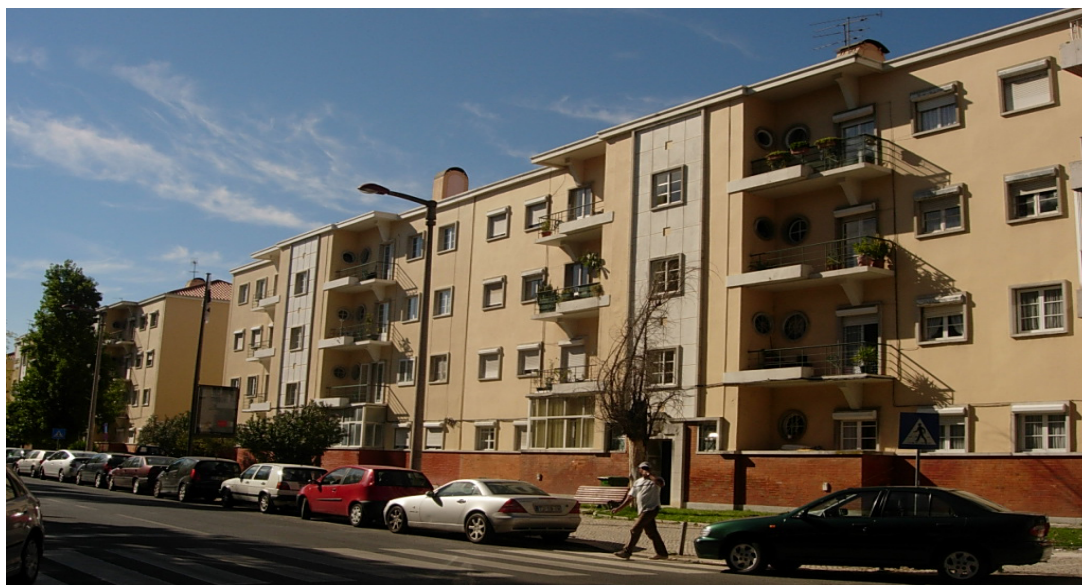
Figura 27 Edifícios de habitação plurifamiliar Série III, tipo 8 (tipologia T3) da Célula 1 na Avenida da Igreja) (Inês Ramalhete, 2007).
