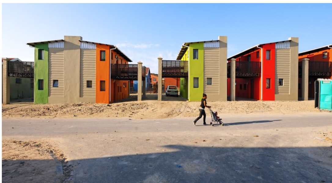
Figura 18 Sandbag Houses, Cidade do Cabo, África do Sul, 2009 (Aaronson, 2012).
