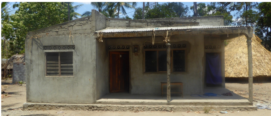
Figura 80 Solução de ventilação através de aberturas na fachada (por cima dos vãos) e solução de ventilação por brise-soleil em vidro (2015).
