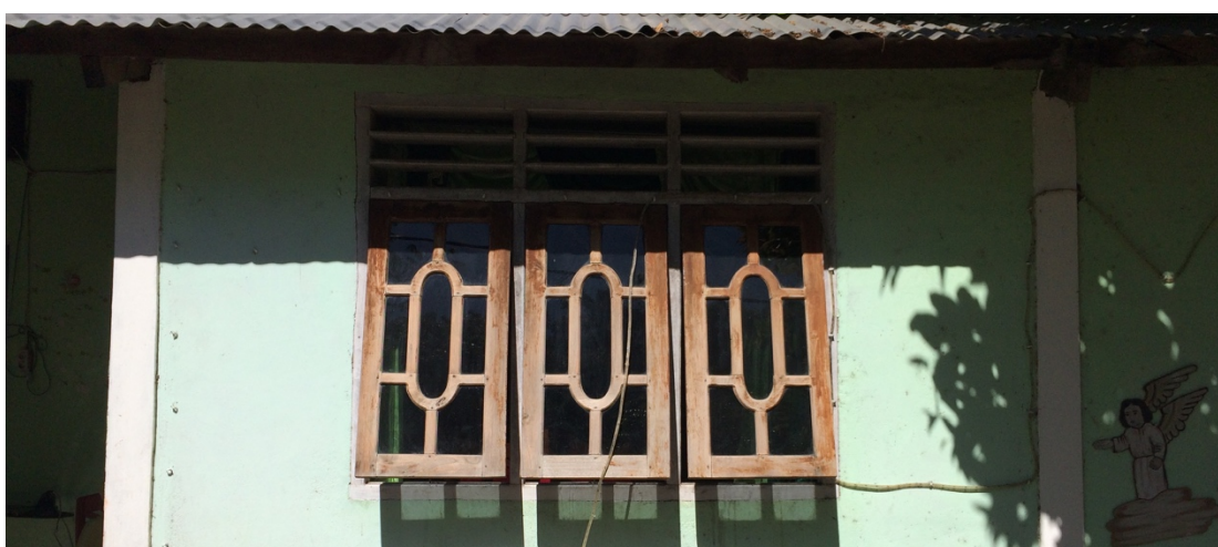
Figura 81 Janela com sistema basculante de eixo horizontal na zona superior (solução corrente, utilizada numa habitação em Pante Macassar).
