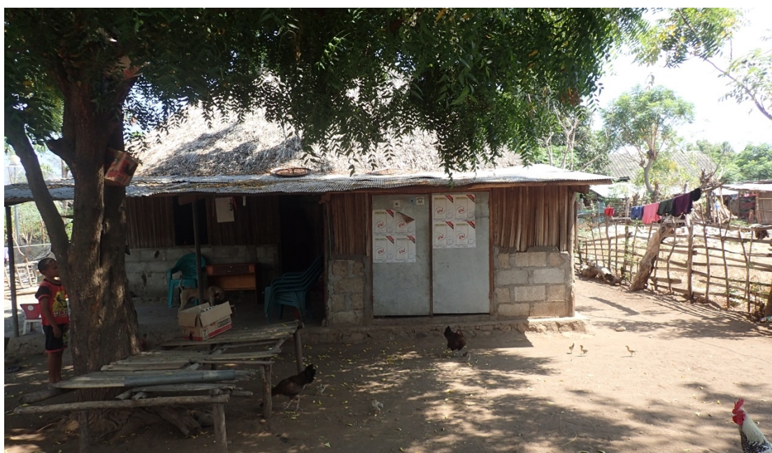
Figura 67 Habitação com sistema de construção misto.
