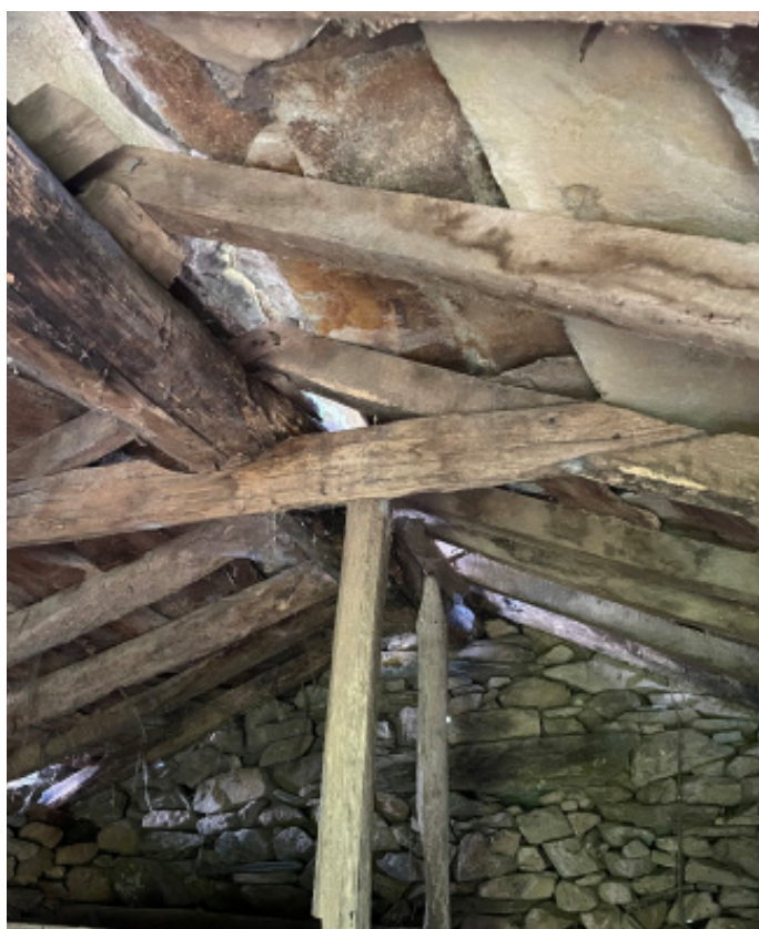
25 e 26 | Construção típica de coberturas em lousa, construído a partir de materiais locais, Serra de Montemuro, junho 2024
