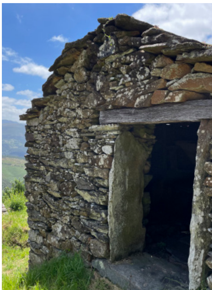
22 | Construção típica de habitações, os vãos e as paredes em pedra, Serra de Montemuro, junho 2024
