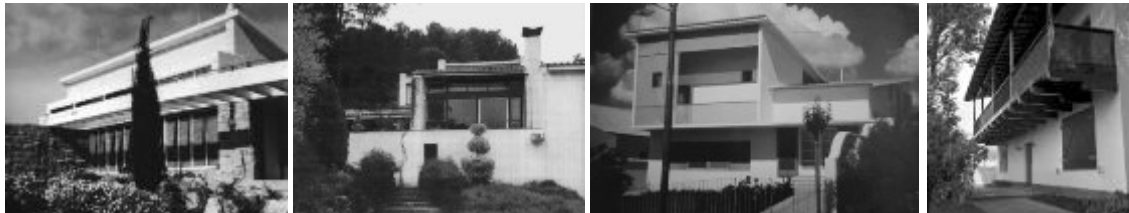
Figura 60 - Casas de revisão do moderno, Lisboa e BH
