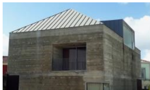
Casa no Azeitão Fonte: Ulisses Morato, 2018.
