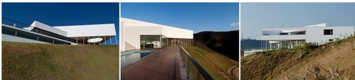
Figura 132 - Fotos da Casa Galeria
