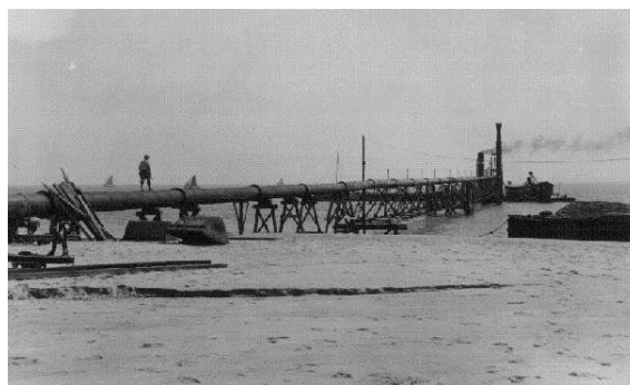
Figura 28 - Obras de construção do aterro, transporte de areia para a implantação da fábrica de Gás da Matinha. Eduardo Portugal, 1938. Fonte: http://arquivomunicipal.cm-lisboa.pt/pt/ .
