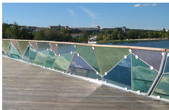
Figura 6 – Ponte Pedonal Pedro e Inês. Fonte: http://www.afaconsult.com/portfolio/91411/92/ponte-pedonal-pedro-e-ines
