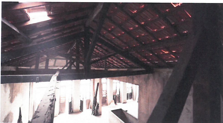
Figura 19 - Goma (antes das obras)
