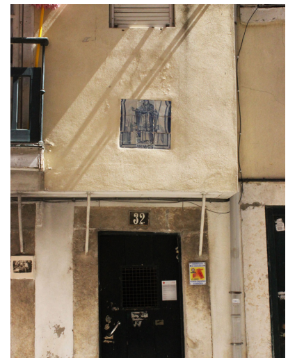
41 O azulejo de São Marçal. Abaixo, um método de controlo de incêndios mais eficiente: a sinalização para um extintor comunitário dentro do edifício. Fotografia da autora.
