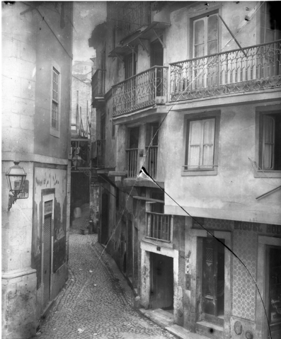
18 Balcões à entrada da Rua do Capelão, alguns apoiados em prumos de madeira. Arquivo Fotográfico CML. C. Ref.: PT/AMLSB/BAR/000079
