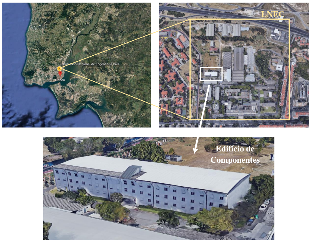
Figura 5-1: Localização do edifício em estudo. Imagem de satélite retirada do Google Earth Pro.
