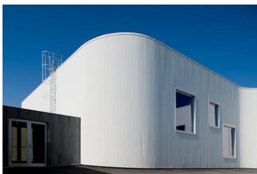
Figura 2 Vista Exterior da Escola D. Dinis
