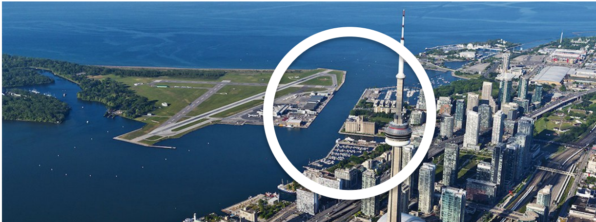
Fig. 65 – Canal Western Gap, Toronto - Canadá.
