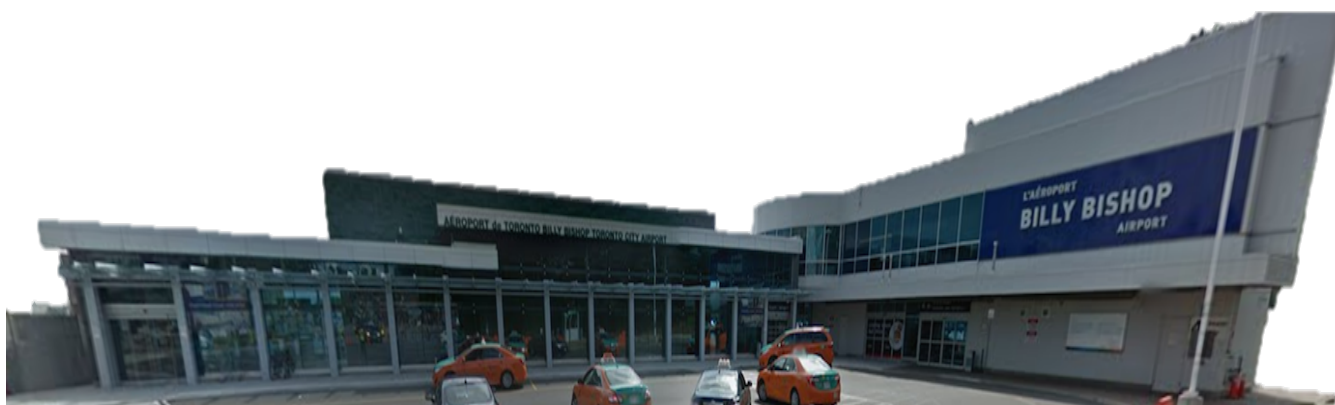
Fig. 67 – Edificação no continente destinada somente ao acesso de passageiros para o terminal, na ilha.
