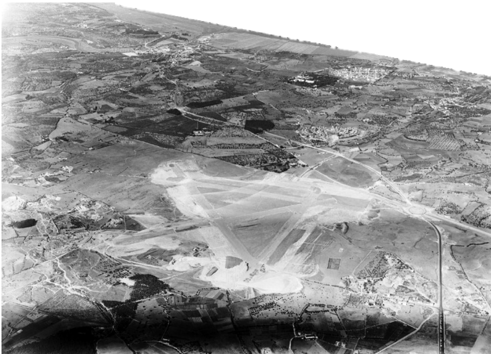
Fig. 69 – Início dos trabalhos de terraplenagem do Aeroporto da Portela (1939).
