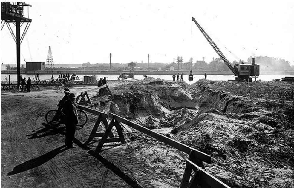
Fig. 61 – Primeira escavação para construção do túnel de pedestres, encerrado posteriormente.
