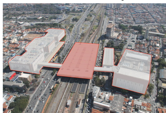
Fig. 86 – Ao centro, a infraestrutura "pesada" do sistema. Lateralmente, os terminais.
