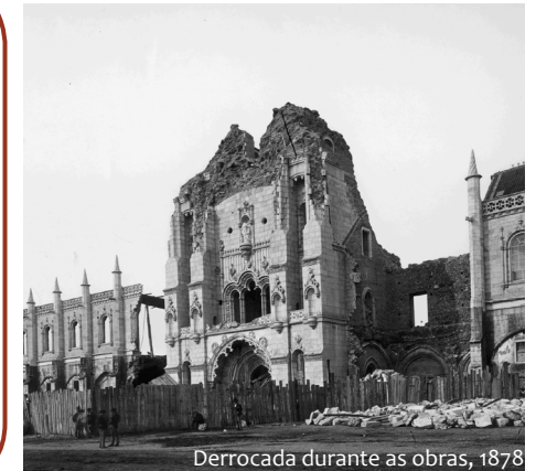
Derrocada durante as obras, 1878
