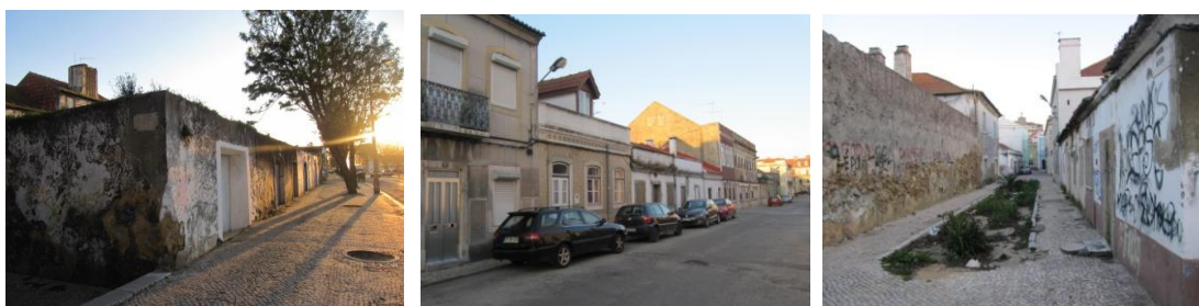
Figura 33 Estado do edificado no Barreiro Antigo
