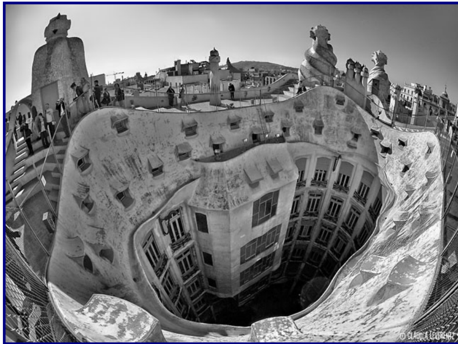
Figura 15 - Casa Milá: terraço do prédio
