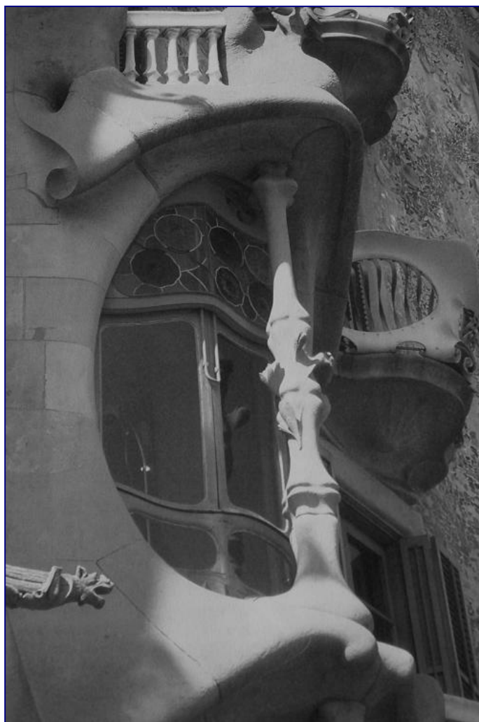
Figura 7 - Casa Batlló: coluna do balcão do primeiro piso (fachada)
