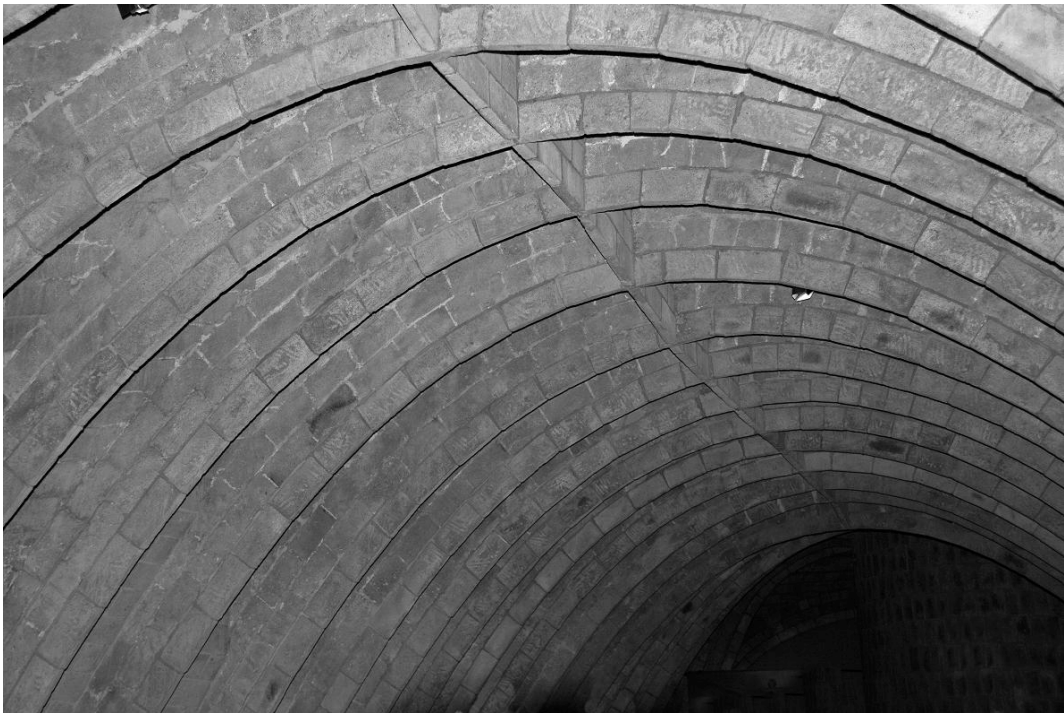
Figura 19 - Casa Milá: sótão (abóbodas)
