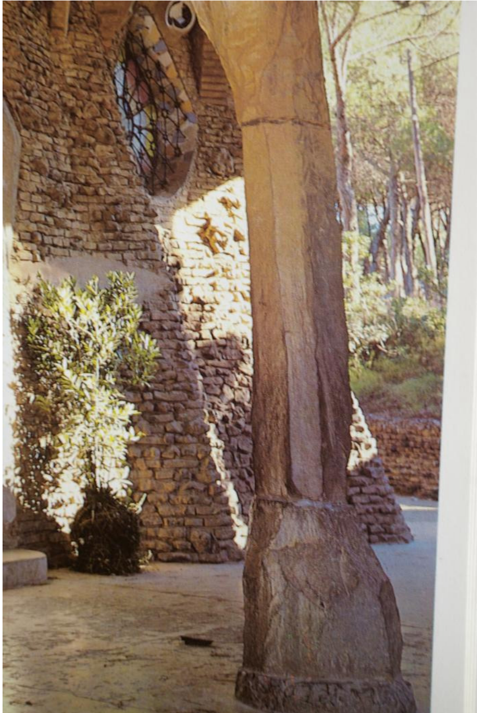
Figura 42 - Colónia Guëll - Coluna (entrada exterior do edifício)
