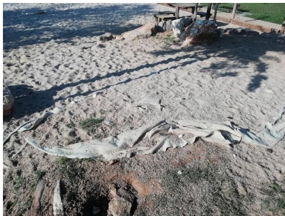
Figura 34 – Manta geotêxtil exposta. Fonte: Rita Leitão, a autora. Agosto, 2018.
