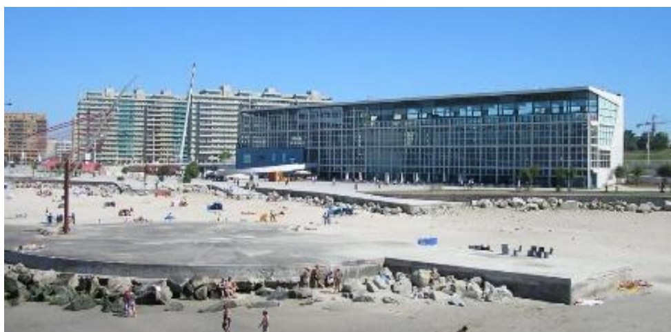
Figura 29. Praia Internacional e Edifício Transparente, localizados no município do Porto. Fonte: https://www.idealista.pt/news/imobiliario/habitacao/2018/10/31/37803-edificio-transparente-no-porto-e-centenas-de-casas-junto-ao-mar-va-ser-demolidos
