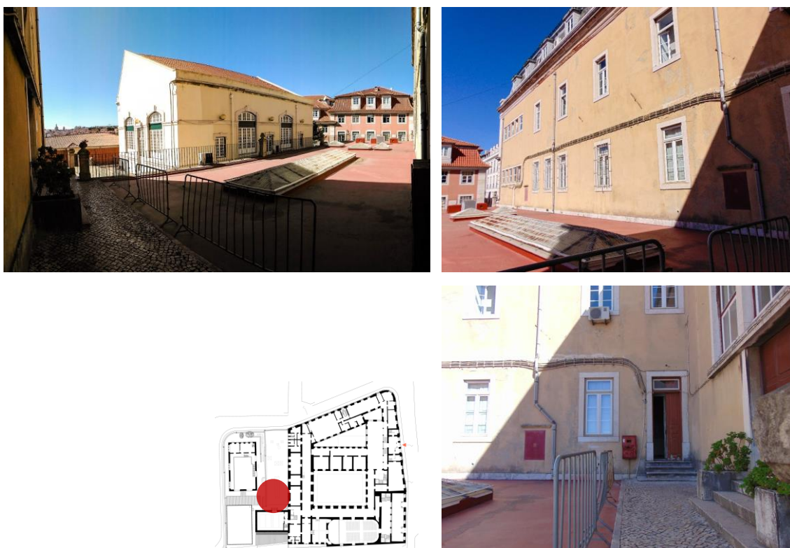
Fig. 83 - Em cima: estúdio 7 da Escola de Dança (esquerda) e fachada poente do edifício do Conservatório (direita, em cima e baixo). Fonte: a investigadora, 2017.
