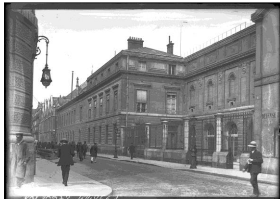
Fig. 35 - Fachada do edifício da Rua Bèrgere em 1912.
