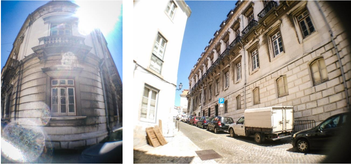
Fig. 128 - Inflexão do edifício do Conservatório (esquerda) e fachada da Rua João Pereira da Rosa (direita). Fonte: a investigadora, 2017.
