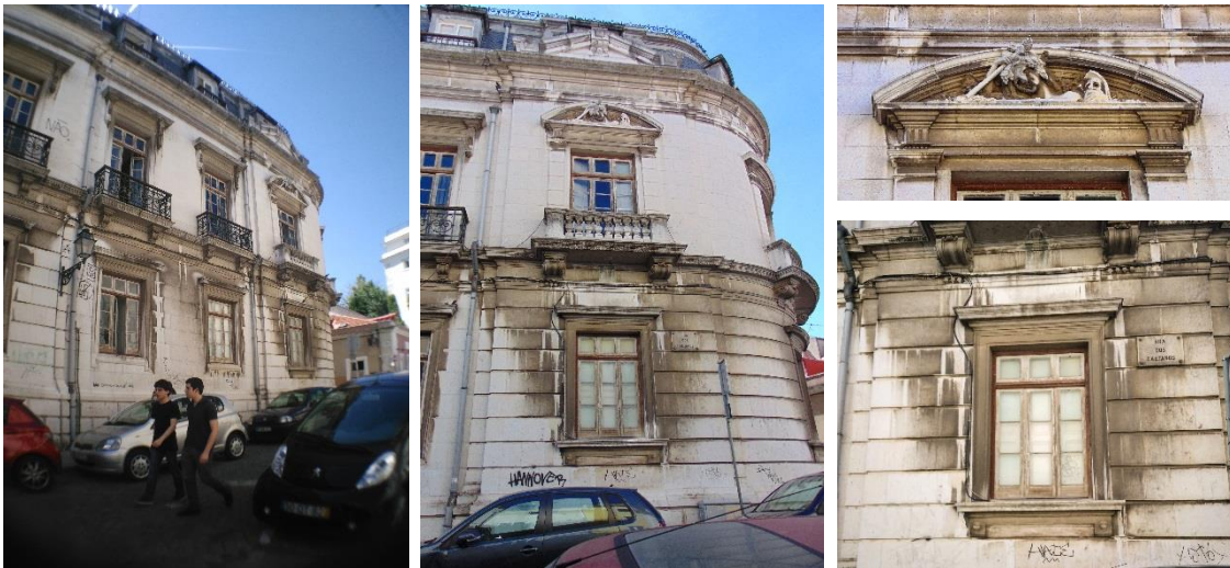
Fig. 59 - Fachada nascente e detalhes dos vãos dos pisos 0 e 1. Fonte: a investigadora, 2017.
