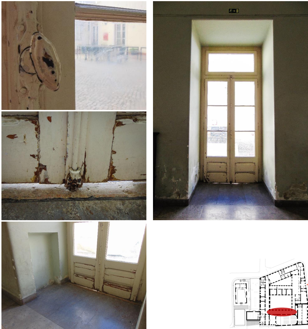
Fig. 74 - Dois tipos de portadas do corredor, que dão para o pátio e pormenores que mostram o estado de degradação das madeiras e ferragens. Fonte: a investigadora, 2017.
