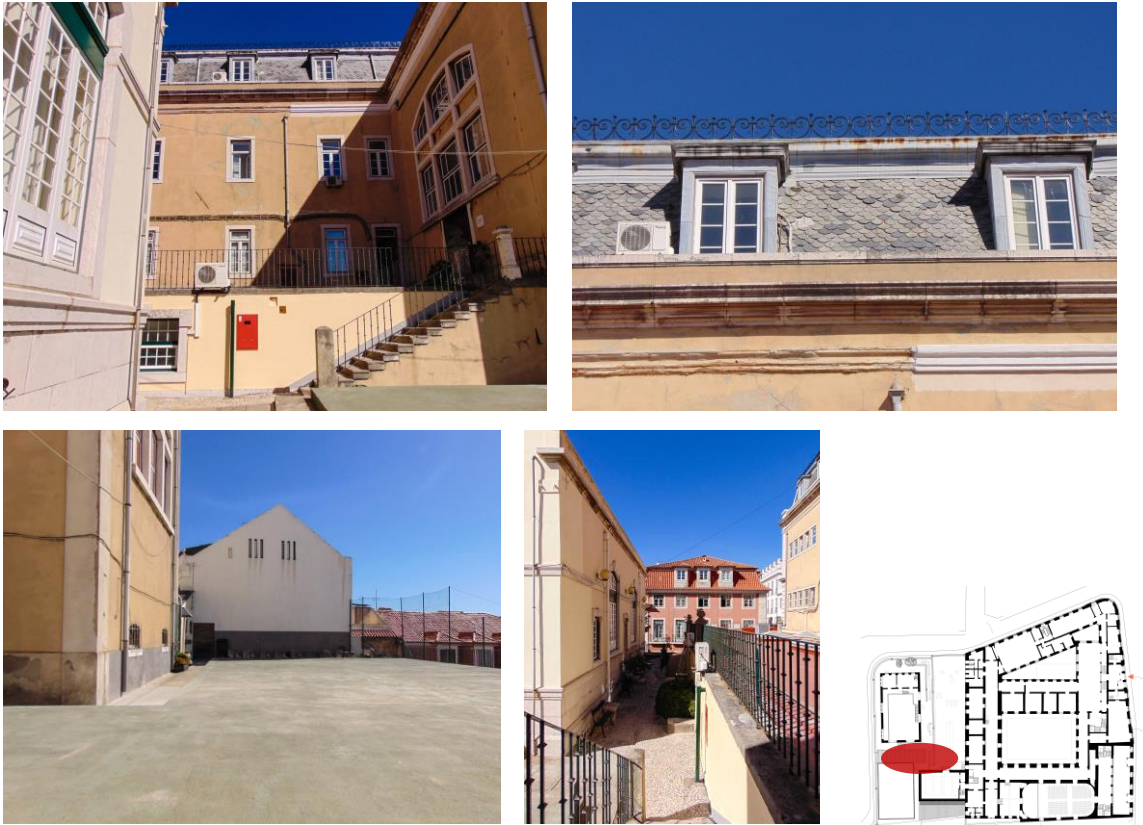
Fig. 84 - Exterior do conservatório: estúdios da Escola de Dança e detalhe do piso amansardado, com revestimento em ardósia (assente em escamas) (em cima, à esquerda). Fonte: a investigadora, 2017.
