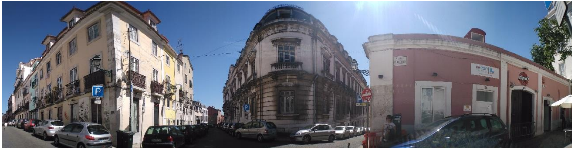
Fig. 45 - Panorâmica da fachada do Conservatório, fotografada na Travessa dos Inglesinhos. Fonte: a investigadora, 2017.
