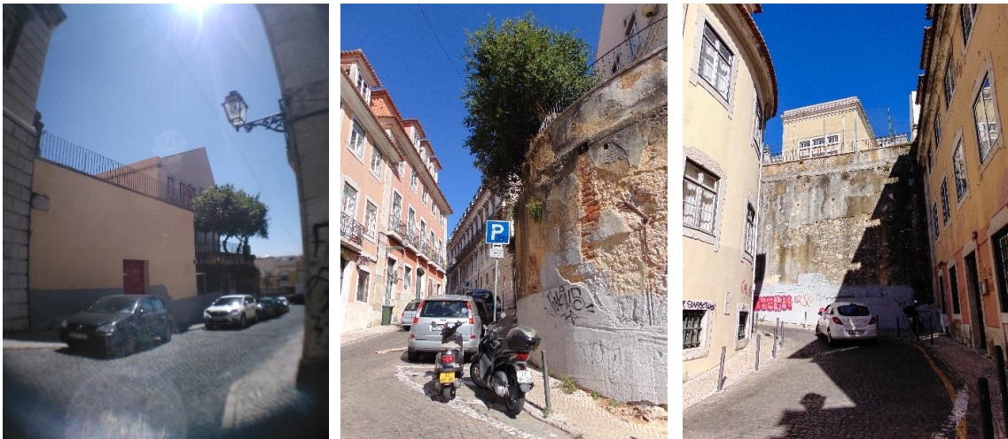
Fig. 129 - Vistas da Rua João Pereira da Rosa, onde se pode ver o muro da cerca conventual (ao centro e à direita). Fonte: a investigadora, 2017.
