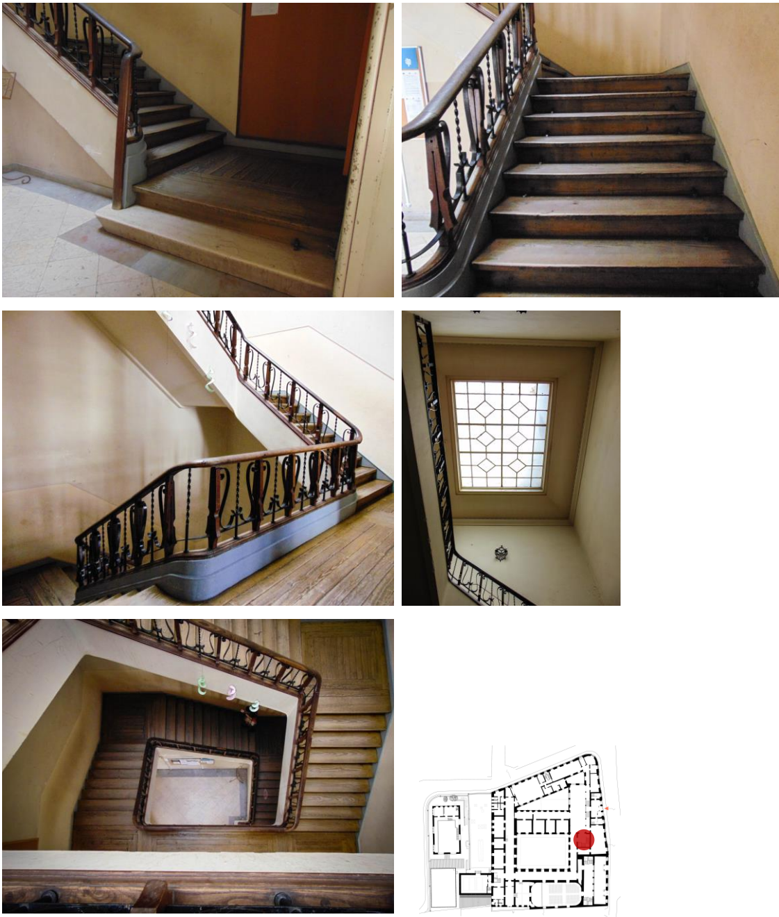
Fig. 67 – Núcleo de escadas perto do pátio central. Fonte: a investigadora, 2017.
