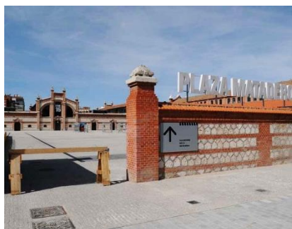
22. Matadero de Madrid em reconstrução, 2009
