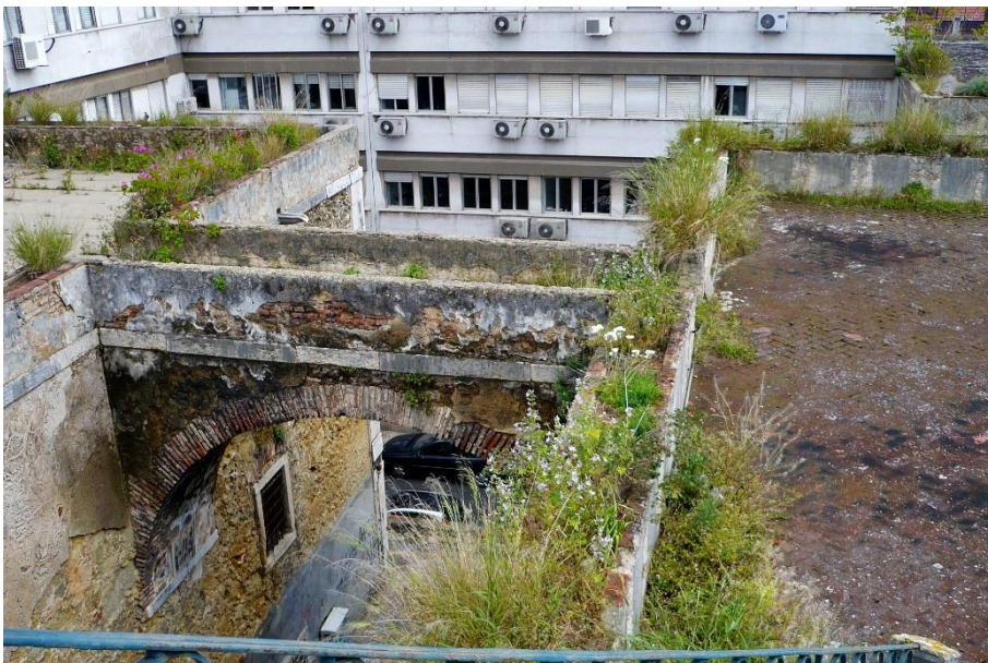
31. Vista das tercenas a partir da Avenida 24 de Julho
