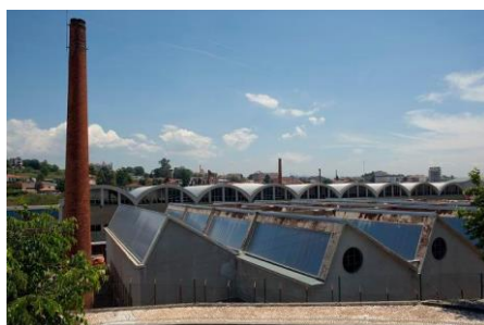
17. Intervenção - vista do conjunto da Oliva Creative Factory
