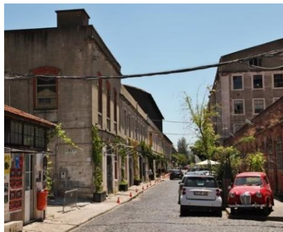
18. Edifício principal da antiga fábrica
