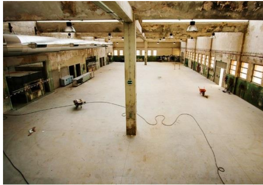
7. Fábrica Oliva - Interior Sala dos Fornos
