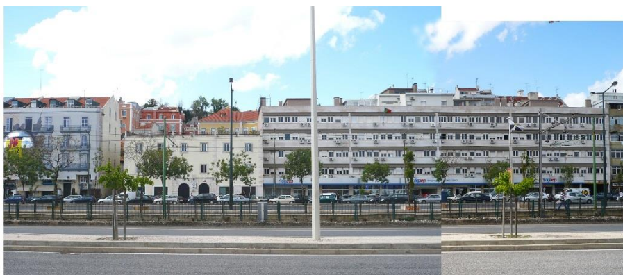
28. Vista das tercenas a partir da Avenida 24 de Julho
