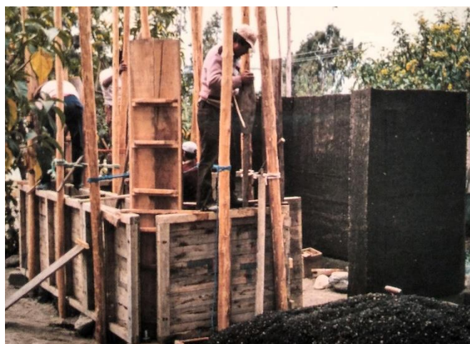
Figura 70 - Construção de paredes em taipa ((Minke, 2021)
