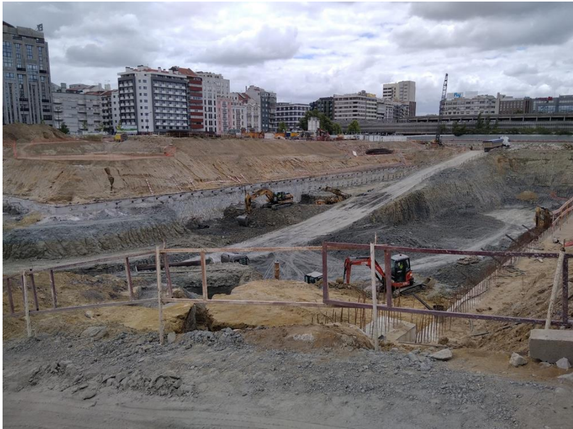
Figura 71 - Aspeto de escavação para construção no centro Lisboa, 2024
