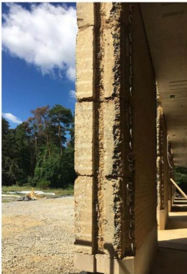
Figura 37 - Bloco de taipa pré fabricado em estaleiro próximo (Transsolar Energietechnik GmbH, 2024)
