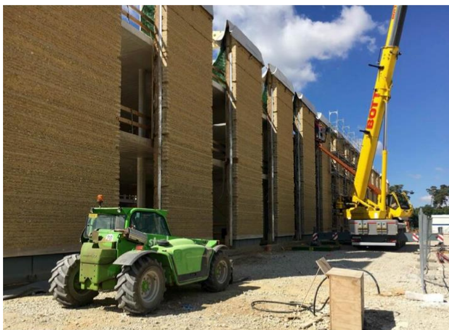
Figura 38 - Montagem das paredes em taipa (Transsolar Energietechnik GmbH, 2024)
