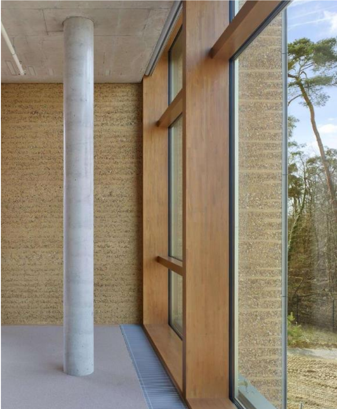
Figura 39 - Aspeto interior das paredes de taipa (haascookzemmrch, 2019)
