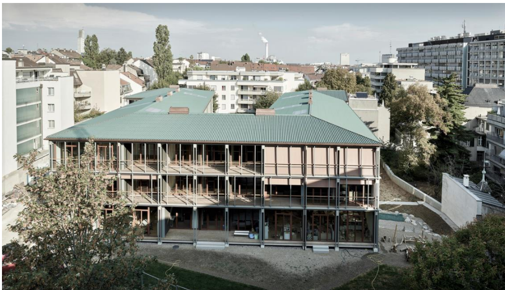
Figura 30 - Aspetto da construção (a+t , 2022)
