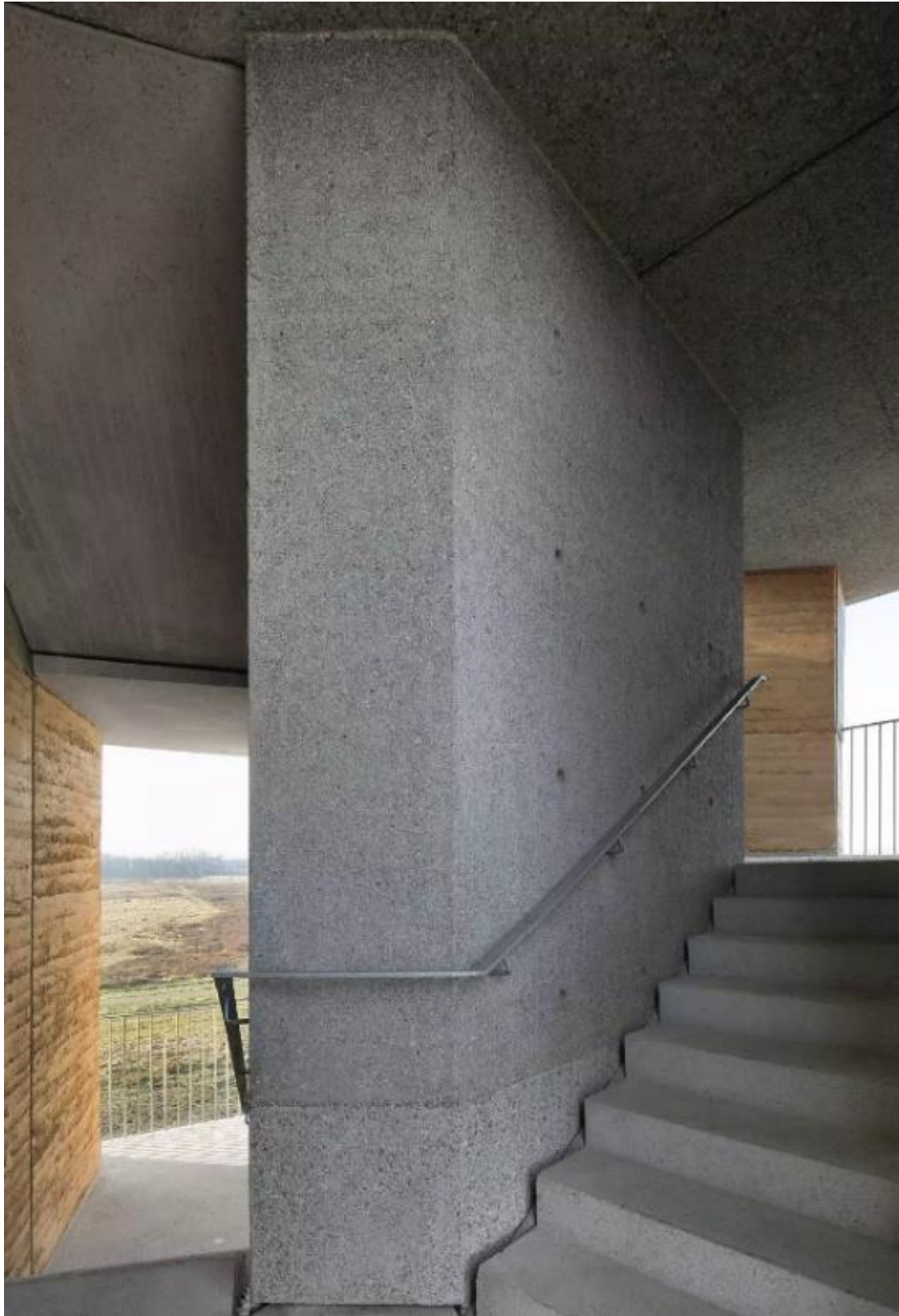
Figura 25 - Torre de vigia Negenoord – pormenor das escadas (ArchDaily, 2021)
