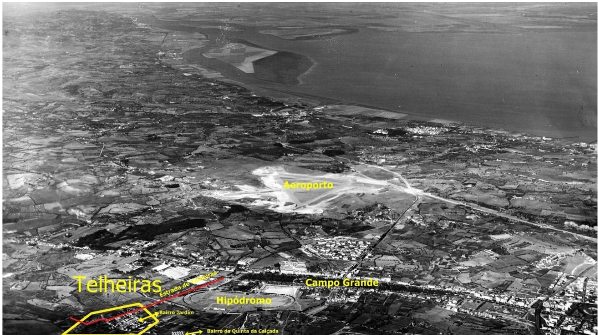
Figura 3 - Aspeto do território do aeroporto (Fonte: Arquivo Fotográfico de Lisboa)
