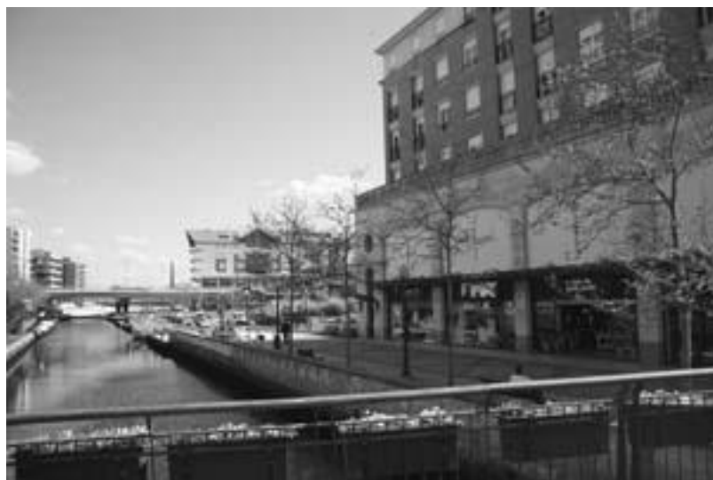
FIG. 21, 22, 23 – Centro Comercial Fórum de Aveiro
