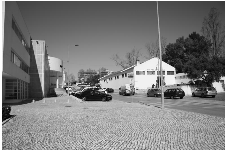
FIG. 24, 25 – Edifício do mercado no Bairro Padre Cruz
