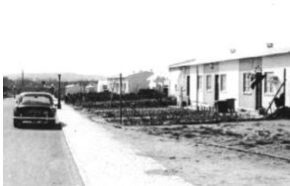
FIG. 30, 31 – Habitações de Fibrocimento
