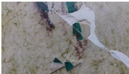
Fig. 59 Espaços escavados no preenchimento para colagem de fragmentos de vidro
