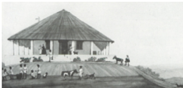
Figura 37 Bungalow como casa da colina / segunda casa dos colonos ingleses, Índia
