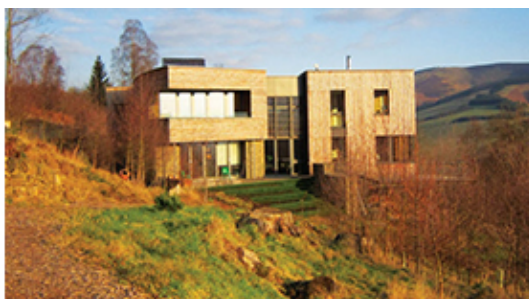
Figura 26 Casa em painéis maciços de madeira lamelada - exterior, Scottish Borders
