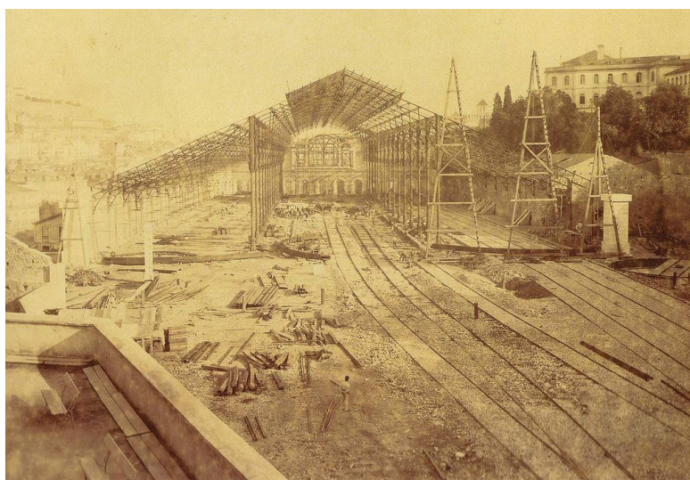
Figura 03 Construção da Estação do Rossio em Lisboa (1886)
