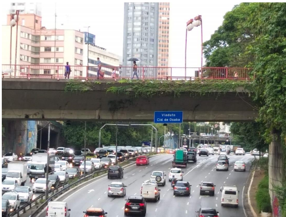
Figura 10 – Viaduto Cidade de Osaka, homenagem aos imigrantes japoneses – Bairro da Liberdade. Foto do autor do trabalho.
