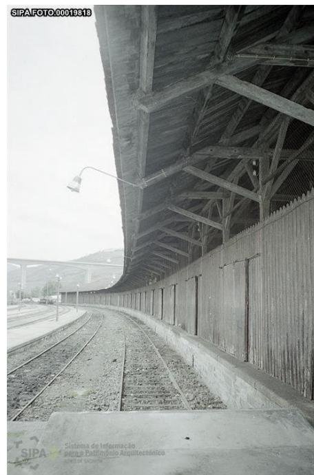
Figura 50 – Armazém ferroviário da Régua, 2008 (fotografia SIPA)
