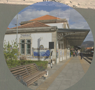
ESTAÇÃO COMBOIOS PINHÃO
