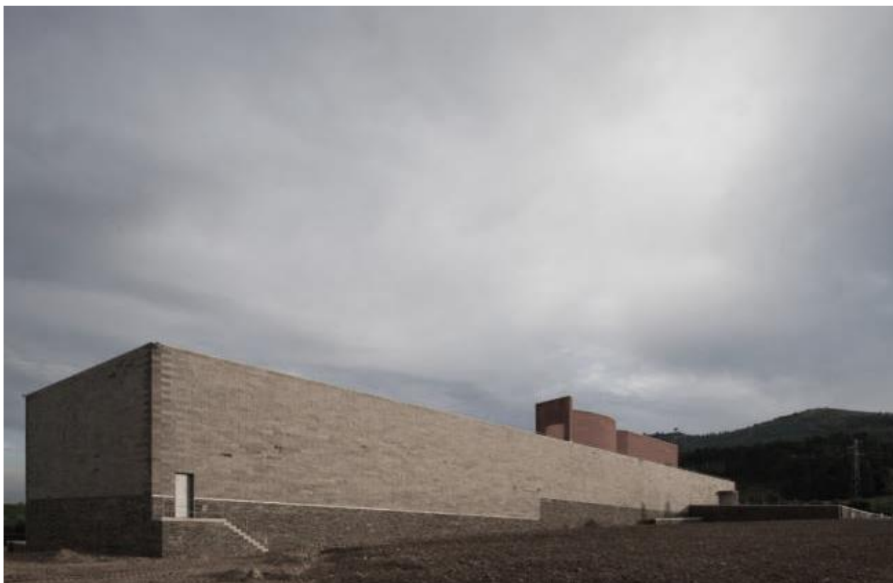
Figura 43 – Armazém Quinta do Portal (fotografia de Quinta do Portal)
