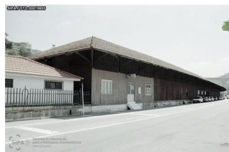
Figura 49 – Armazém ferroviário da Régua, 2008 (fotografia SIPA)
