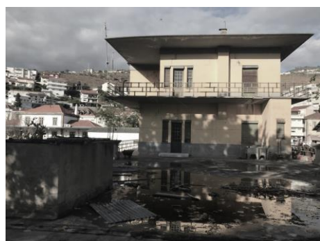
Figura 14 – Alçado Sul Casa do Douro, 2019 (fotografia de autor)
