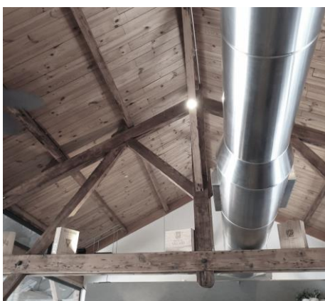
Figura 51– Armazém ferroviário da Régua (fotografia de autor, 2019)
