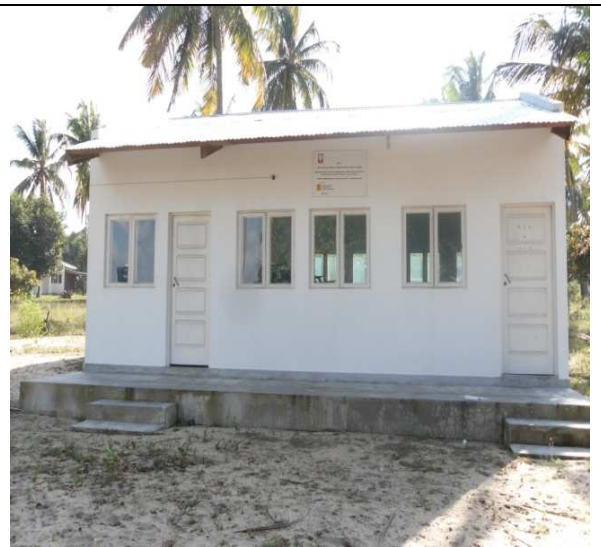
Ilustração 8: Sala de formação - Centro de Formação e Desenvolvimento de Salela, construído pela Cáritas Moçambicana – Cidade de Inhambane
