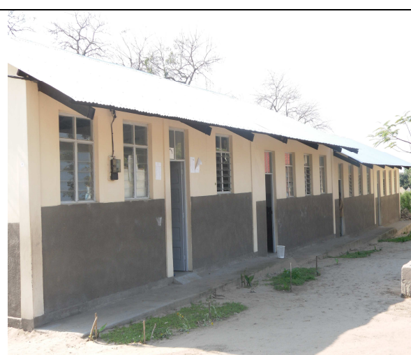
Ilustração 2: Salas de aulas construídas pela WRI: EPC de Mucotuene – Chibuto
