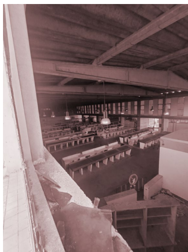
Figura 20 - Interior Mercado Póvoa de Santo Adrião
