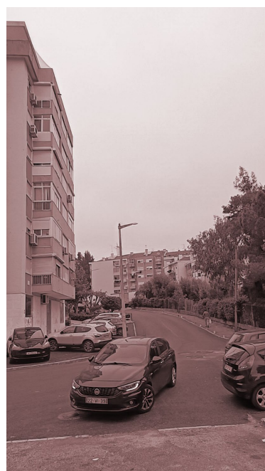
Figura 16 - Passeios inexistentes ou ocupados por viaturas
