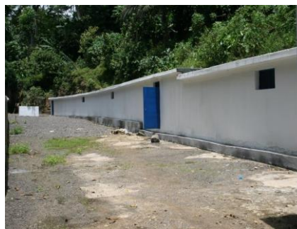
Figura 4: Fonte de captação de água subterrânea (Sistema de Água Amoreira I) (EMAE, 2016).
