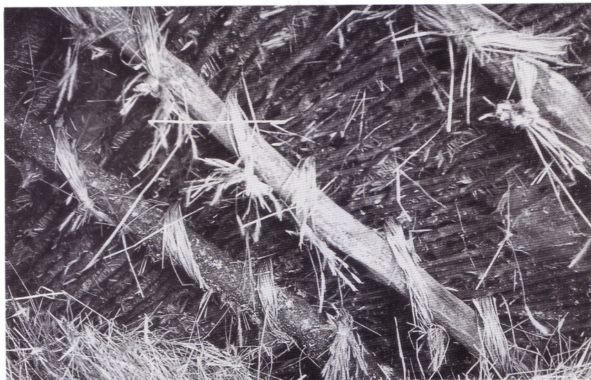
fig.26. Interior de uma cobertura em colmo onde são visíveis os bancelhos amarrando o ripado de varedo.
