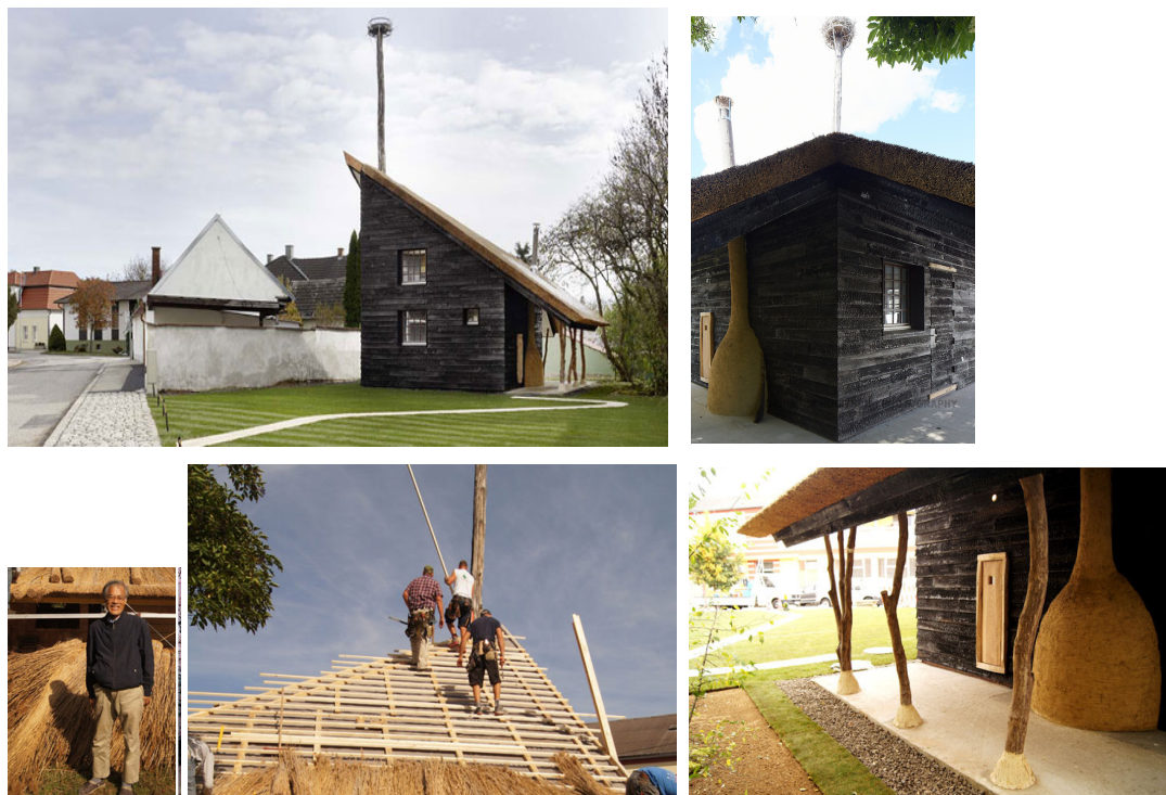
fig 45 Projecto do arquitecto japonês, Terunobu Fujimori, para o Raiding Project, a Storkhouse (casa da cegonha), feita utilizando processos de construção tradicionais japoneses, incluindo o telhado com cobertura de colmo. Podemos observar numa das imagens a colocação da cobertura. (imagens retiradas do site www.raidingfoundation.org )
