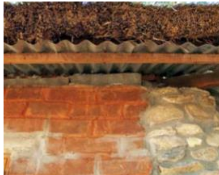
Fig. 12 | Cobertura com colmo.
