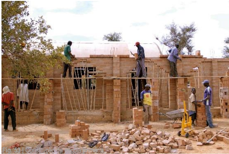
Fig. 53 | Construção da escola primária
