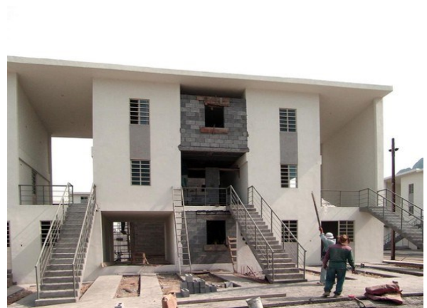
Figura 19 - Fotografia do projeto Habitação Monterrey em construção para ampliação, por desconhecido. https://www.archdaily.com/52202/monterrey-housing-elemental
