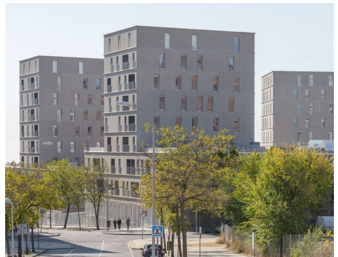
Figura 24 - Fotografia do projeto 159 Social Housing Units in Madrid, por desconhecido. https://www.architonic.com/en/project/taas-totem-arquitectos-asociados-159-social-housing-units-in-madrid/20719004
