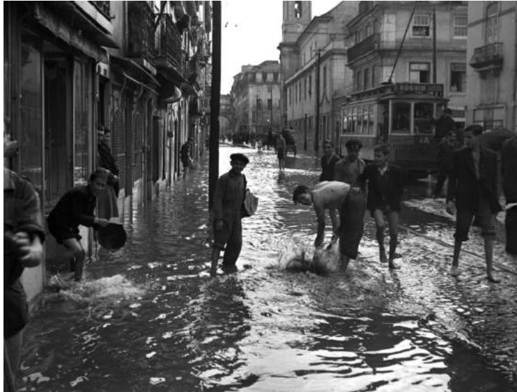
Figura 35. Inundações na Rua de São Paulo, Lisboa em 1945. Fonte: http://www.paixaoporlisboa.pt/lisboa-1945-cheias-97154
