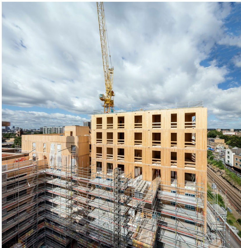
Fig.16 | Edifício em construção (Waugh Thistleton Architects)
