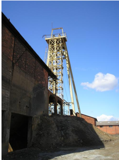
Fig.2.3: Poço Malacate nº1 e antiga estação de moagem de minério.
