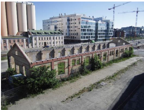
Figura 55 - Armazém de Mercadorias antes da requalificação.
