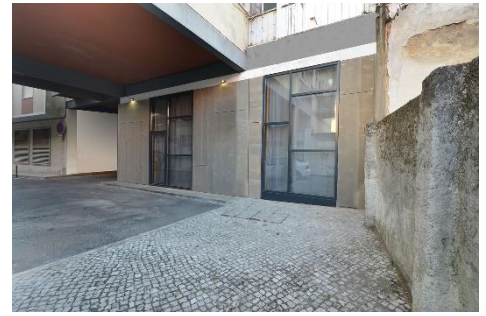
Figura 80 - Fabrica da Cortiça - Cowork. Fonte: Archdaily.com
