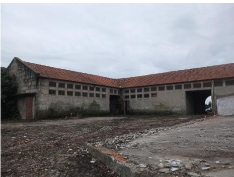
Figura 73 - Edifício anterior à requalificação. Fonte: Archdaily.com
